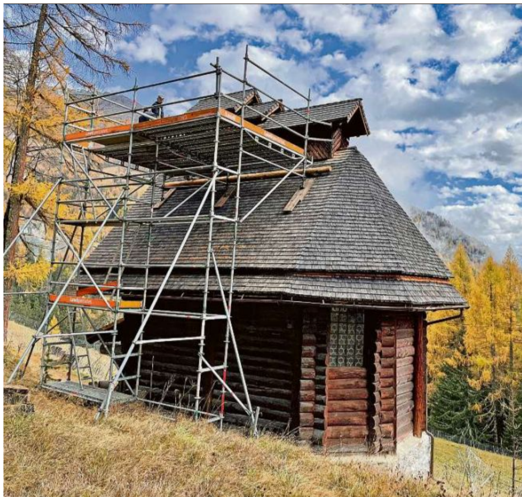
Eingerüstet: Das Glockenspiel wird wieder montiert.
